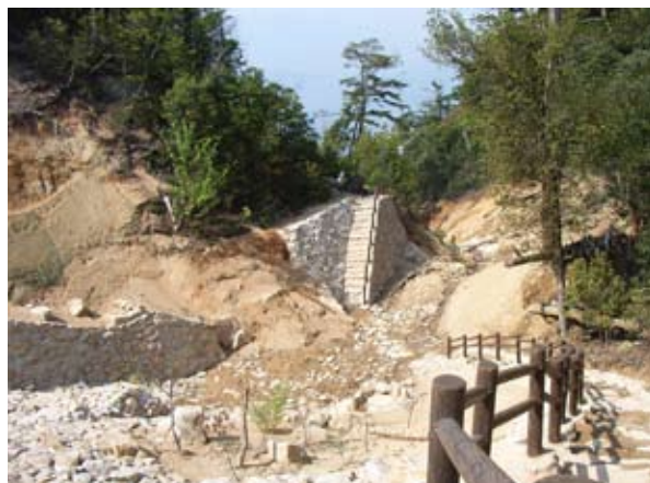
白糸川上流の崩壊地の復旧の様子。第一堰堤付近の歩道 (宮島白糸川, 2007年5月8日撮影)
