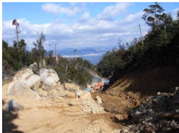
白糸川上流の崩壊地の復旧の様子。約400m地点から北側を望む。中央が堰堤(宮島白糸川, 2007年1月31日撮影)
